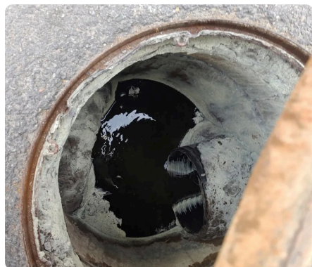
潮湿、多尘、水面漂浮物多的窖井工况
