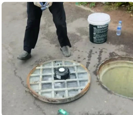
现场安装：井盖下方固定，透镜朝向液面
